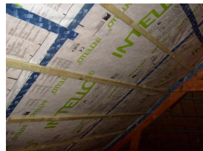
Isolation toiture + pare vapeur
