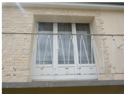
Isolation des murs par l'extérieur
